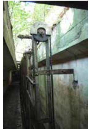
Abb. 3: Deckenöffnungen des Zielzonenganges
